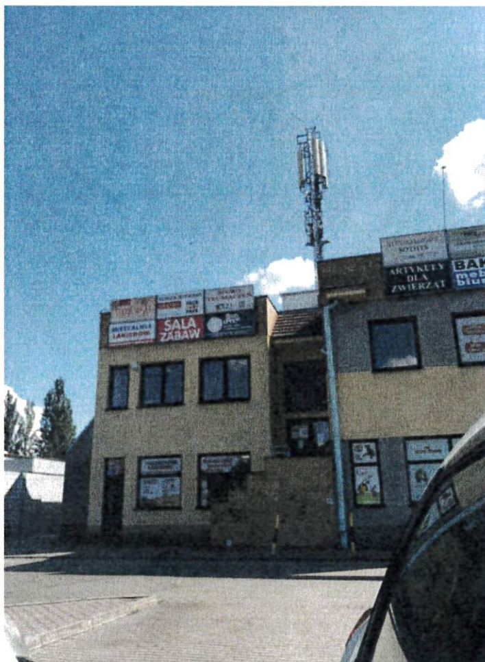
Zał. nr 1: Widok ogólny instalacji radiokomunikacyjnej.
