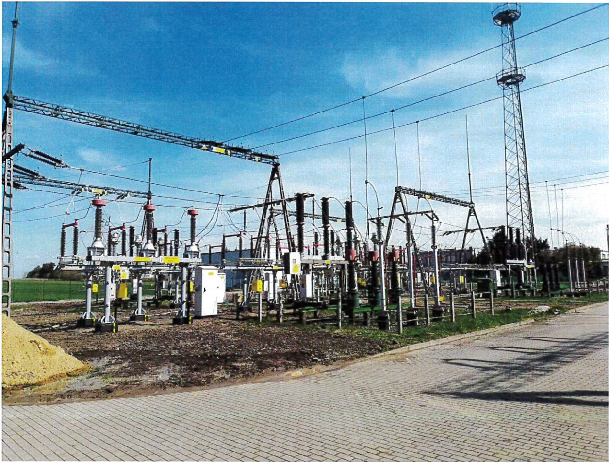
Zdjęcie 1 Badany obiekt
