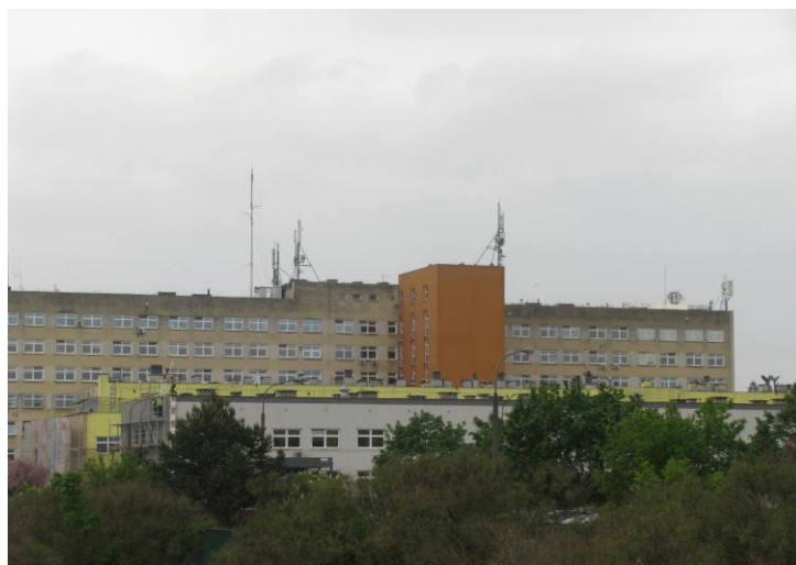
Zał. nr 1: Widok ogólny instalacji radiokomunikacyjnej.
